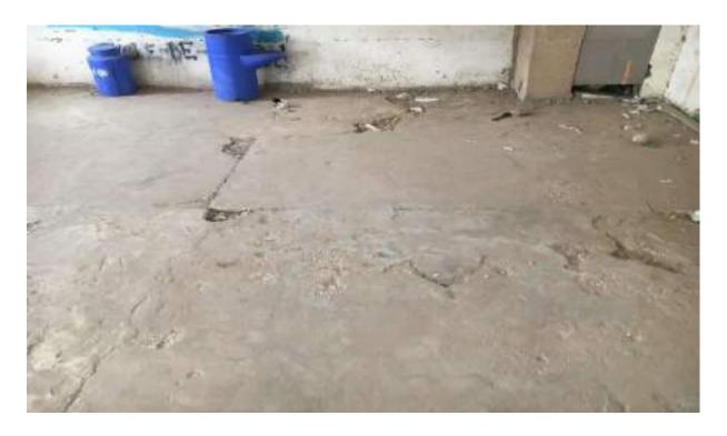
3. Remise en état avec renforcement du béton armé du revers d'eau ceinturant le bâtiment :
